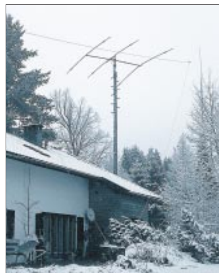
Bild 7: Die aufgebaute Antenne wirkt recht unauffällig. Fotos: Autor
